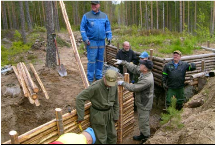
Rauhanturvaajien linnoitustalkoiden yhtenä kunnostuskohteena kesällä 2015 Miehikkälän Salpalinja-museolla oli taisteluhaudan puuverhouksen uusiminen.
